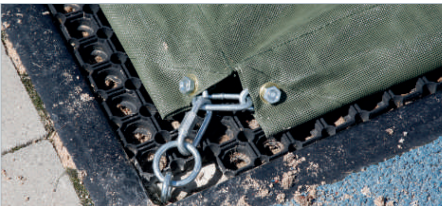
Variante zur Eckbefestigung der Beschwerungskette
